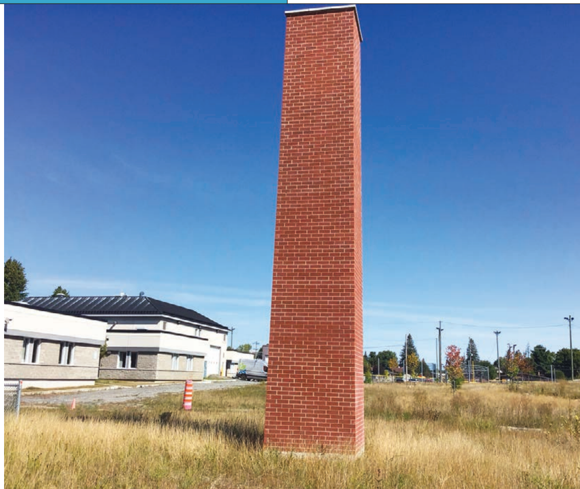
Sur la photo, une nouvelle cheminée fraîchement érigée à Magog en Estrie sert de refuge aux martinets ramoneurs, une espèce d'oiseaux protégés qui fait son nid dans les cheminées.
